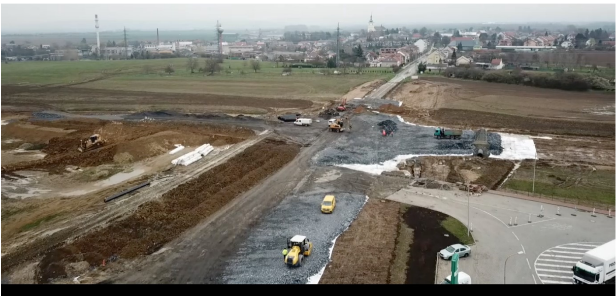
Výstavba u čerpací stanice Prim u Velkého Týnce.
