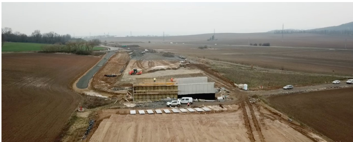
Výstavba nového podjezdu pod dálnicí směrem ke grygovské skládce.
