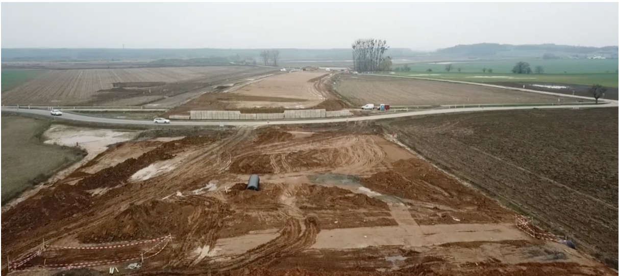
Výstavba směrem na Majetín, za odbočkou na Zepiko.
