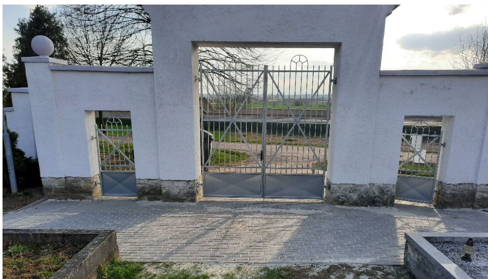
Nová vstupní brána a zrekonstruovaný vstup na hřbitov.
